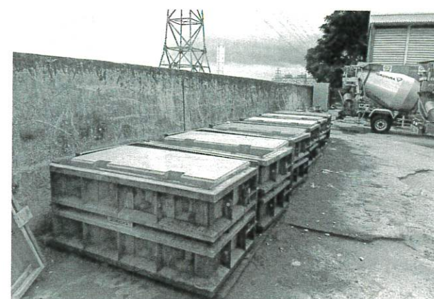
12個の型枠で日々6個ずつ製作
