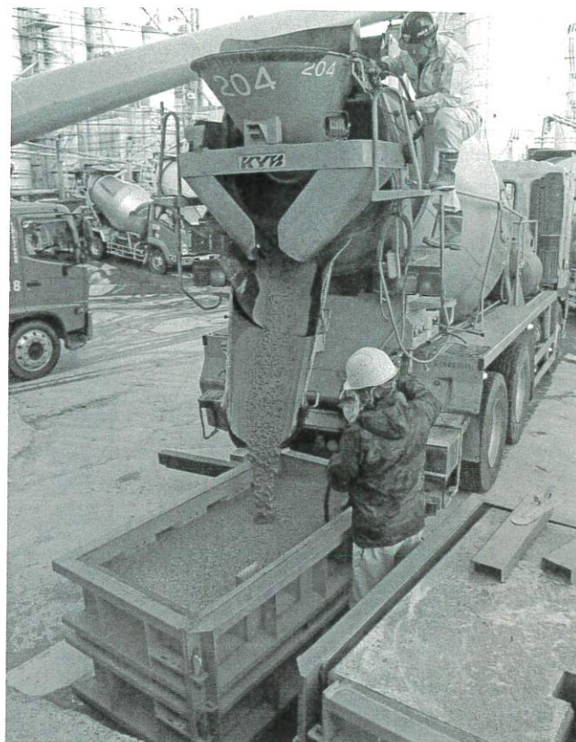
余剰コンによるブロック製作
